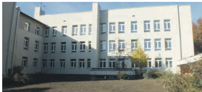
Budynek DPS w Zaskoczynie po termomodernizacji.
