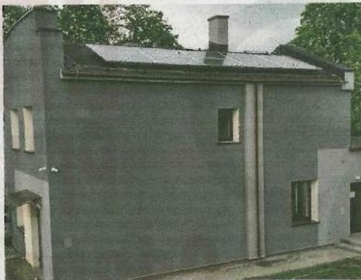
Budowa instalacji ogniw fotowoltaicznych to kolejna duża inwestycja w gminie Przywidz realizowana ze środków UE
